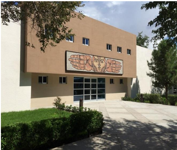
Edificio A del IADA
