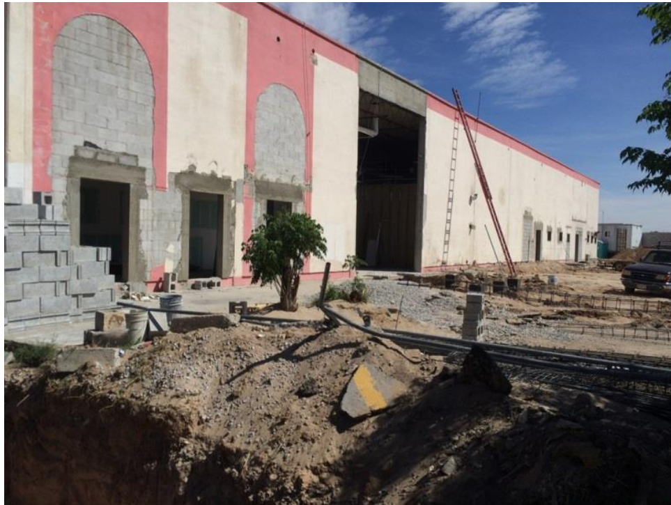
Edificio de laboratorios del IIT
